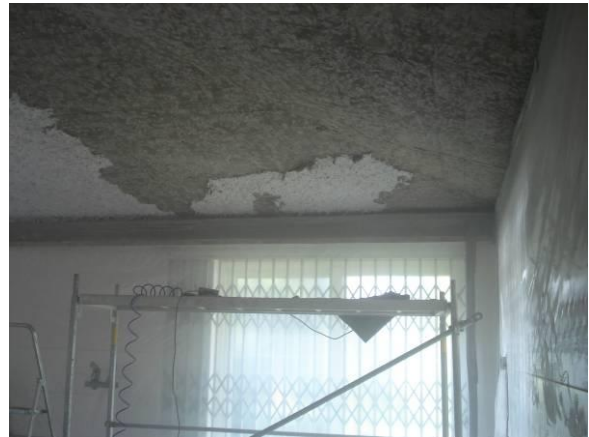
Figura 18 – Revestimento de tecto
