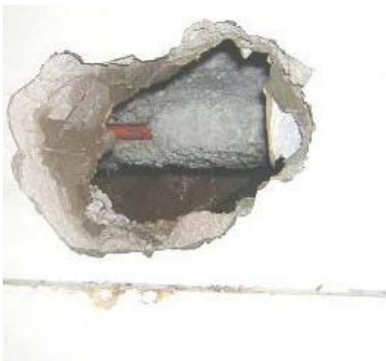
Figura 4 – Isolamento de tubagem embutida na parede
