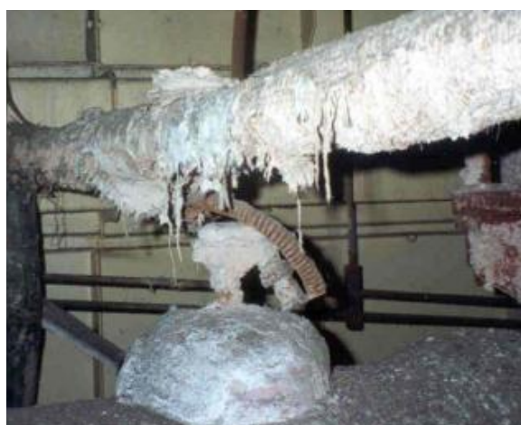
Figura 9 – Isolamento térmico de conduta de vapor
