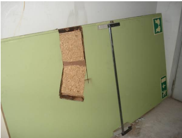
Figura 16 – Interior de porta corta-fogo
