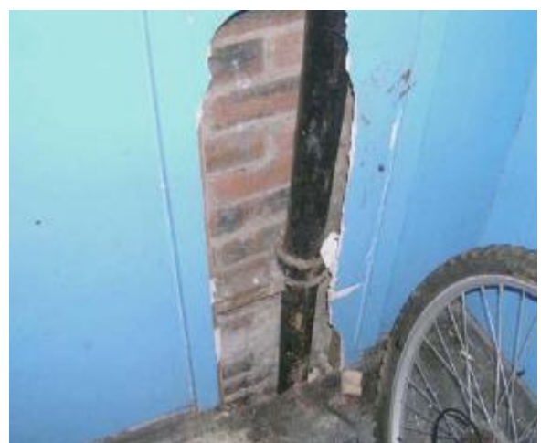
Figura 14 – Painel de isolamento contendo amianto
